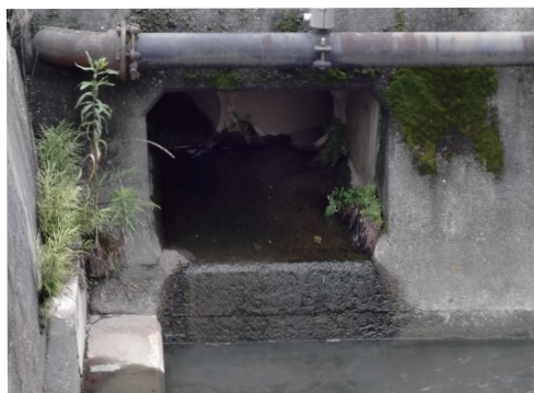
区域内(下流)水路の踏査
